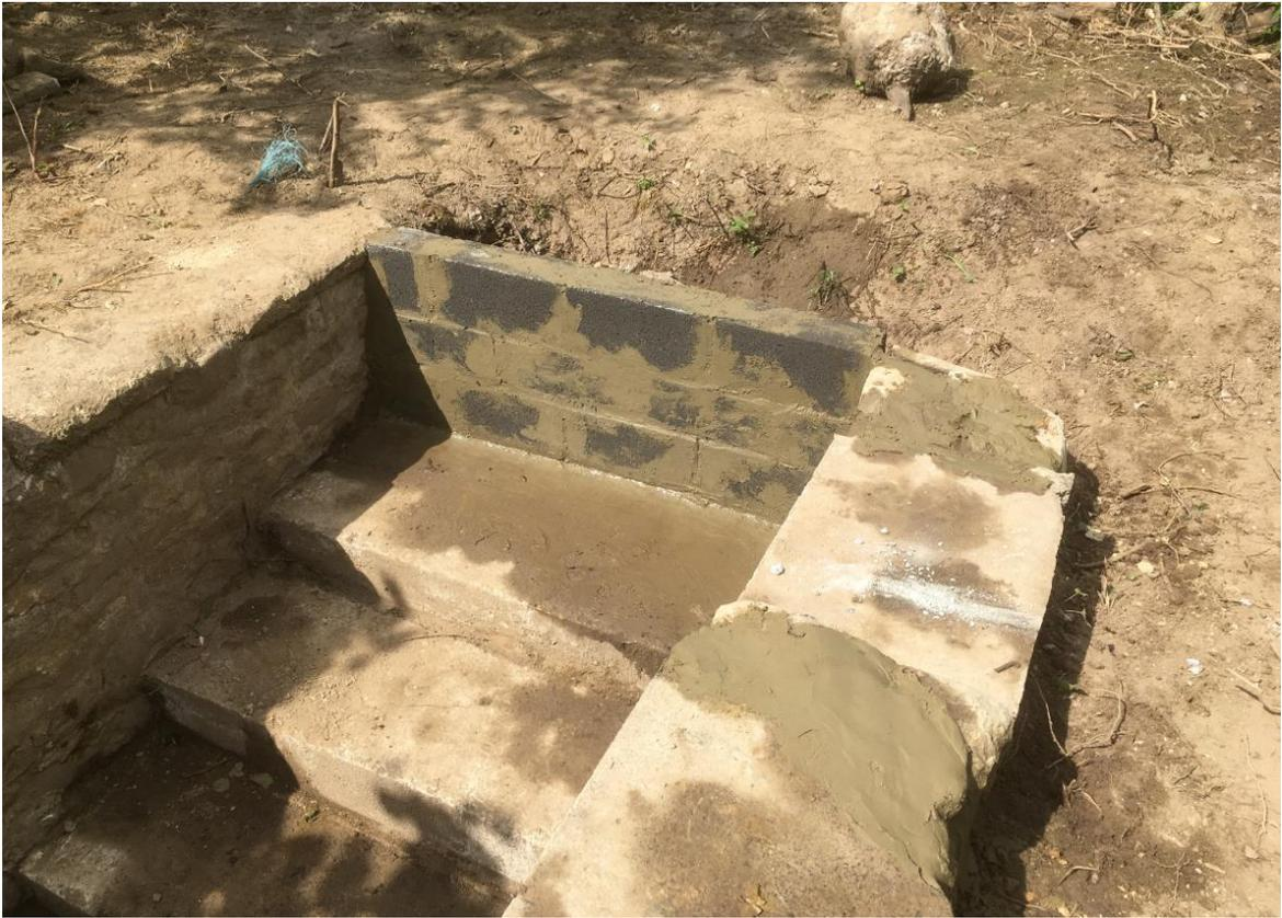
Travaux de maçonnerie réalisés au niveau de l'escalier d'accès du local des pompes
